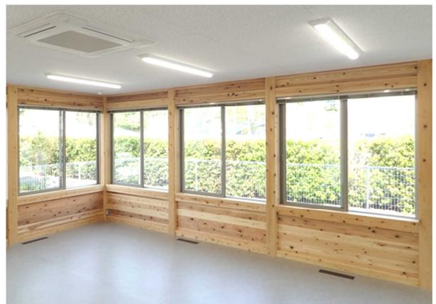
図 5 連結ラーメン構造による建築物 (事務所)
