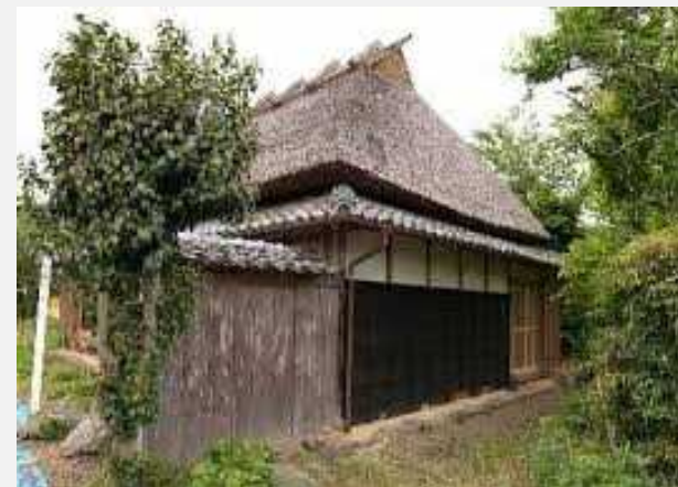
国庫補助事業で修理された土居 廓中唯一の茅葺き家屋
