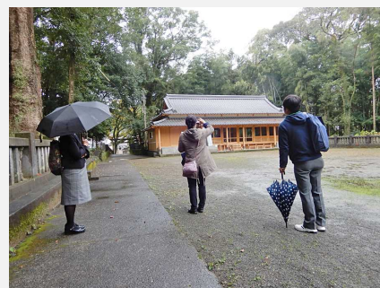
(1) 修理修景事業 久礼八幡宮直会殿
