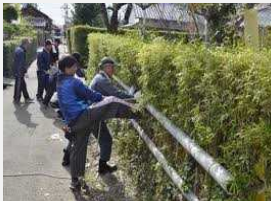
(1) 生垣押し縁の取替え
