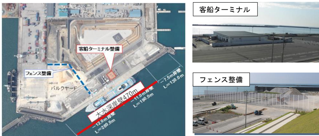
図 1-56 客船ターミナルとフェンス整備の状況
