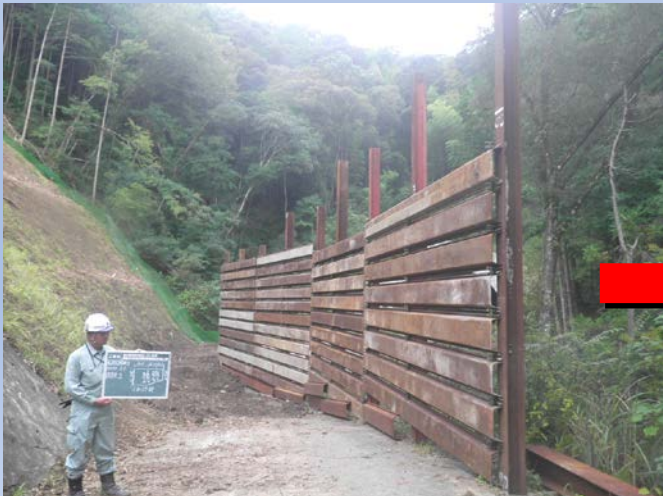
金属壁に飛石が発生する高音を抑制
