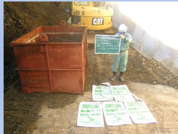
練り混ぜ状況
