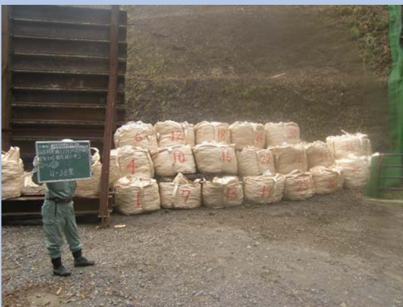
④ 端部は大型土のうで流出防止
