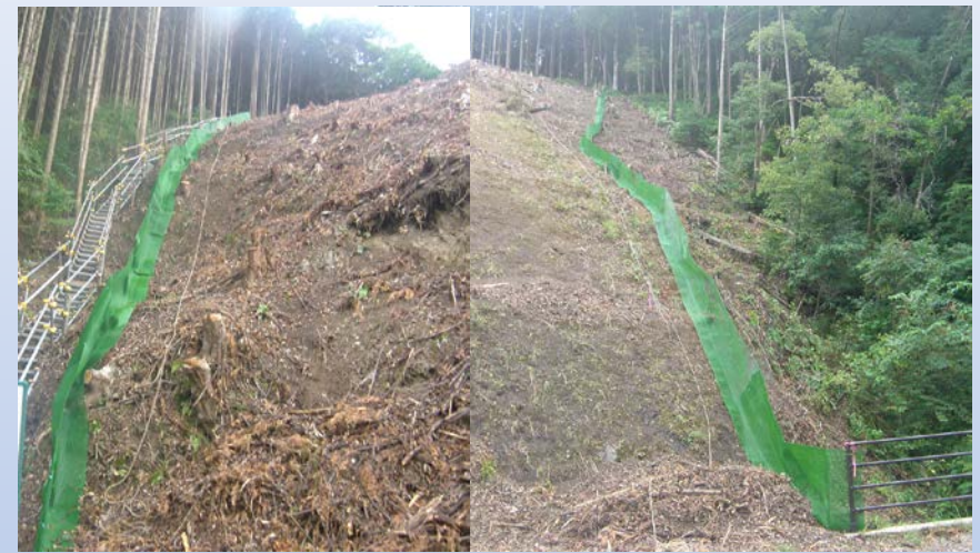
③ ネットで用地外への土砂の飛散を防止
