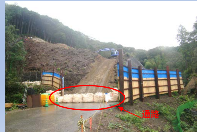
⑥ 降雨前には出入口も大型土のうで流出防止
