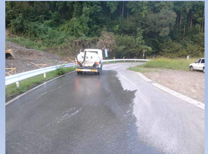
残土場周辺の一般道路の清掃
