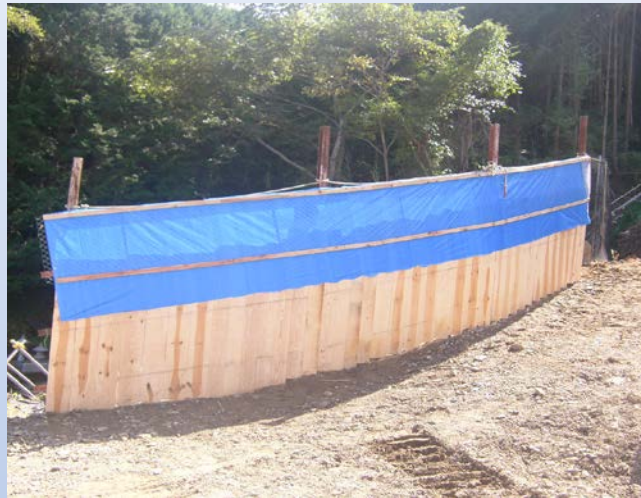
② 木製の土留は飛散, 流出に対応
