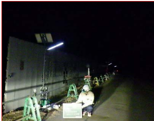
ソーラー式 照明設置
