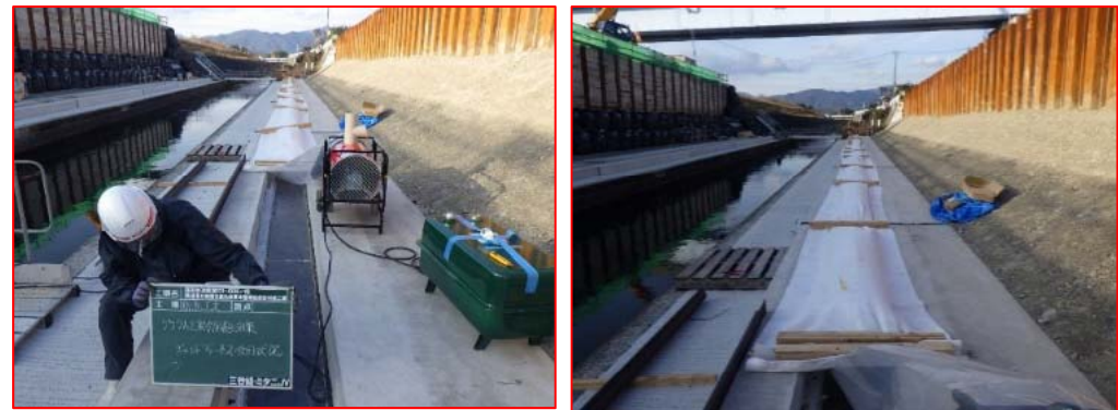
加熱養生(1次グラウト時)
