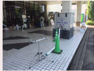
仮設給水タンクによる給水
