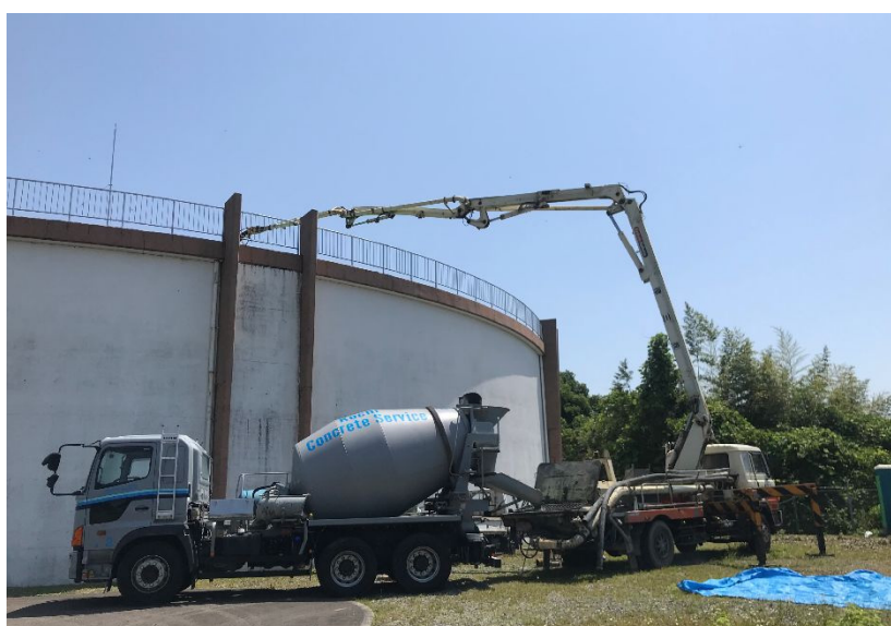
図 6-11 南部配水池耐震補強工事
