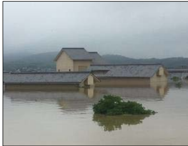
約4.2m浸水（倉敷市真備浄化センター）
