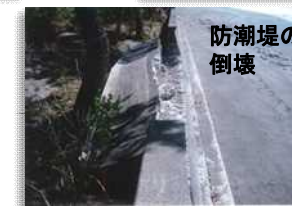
防潮堤の老朽化による被害
