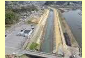
日下川(堤防整備)
