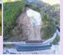
県道安田東洋線(法面防災)
