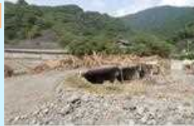
伊尾木川(河床掘削・流木撤去)
