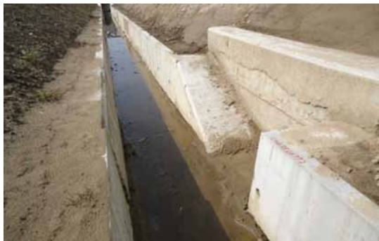
排水路完成状況
