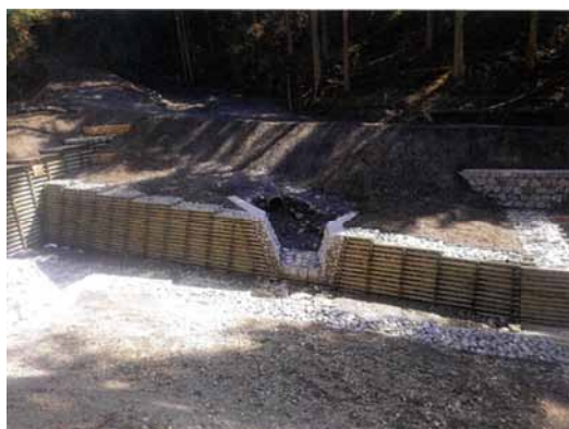
護岸工 (木製) 完成状況
