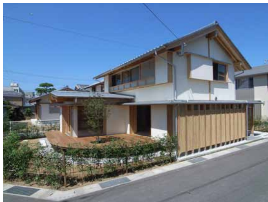
木造住宅（外観）
