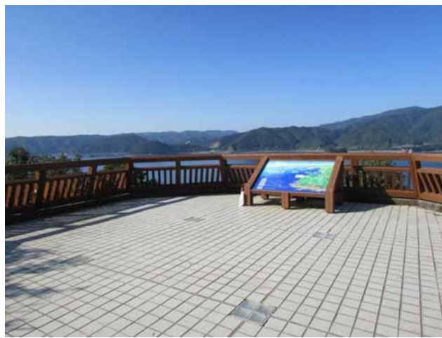
見残園地展望台手摺改築工事
