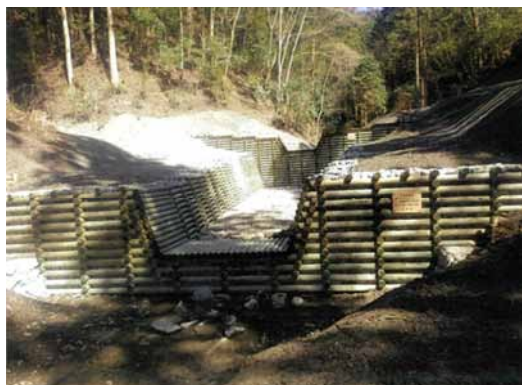
床固工 (木製) 完成状況
