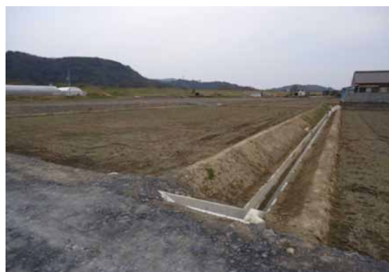
工事完成状況
