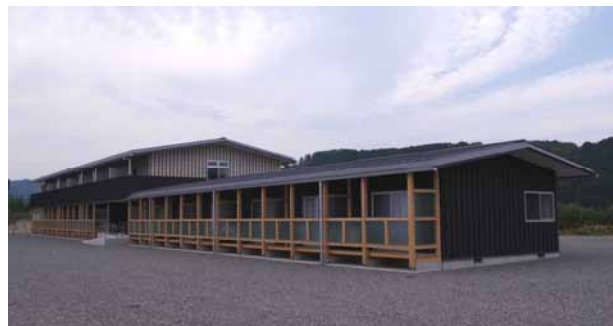
県立農業担い手育成センター長期研修用宿泊施設 (平成 28 年 4 月完成) (CLT 構造 延べ床面積 724 \text{m}^2 )
