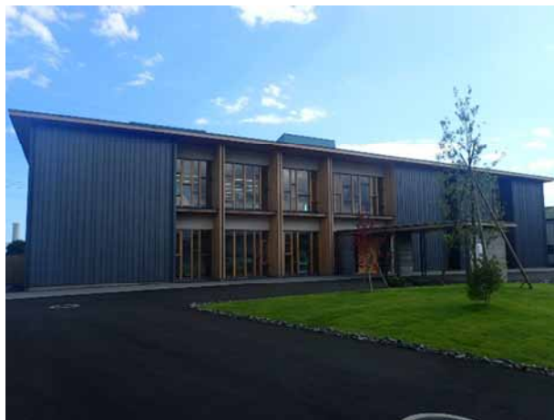
高知県森林組合連合会事務所（平成28年3月完成） （木造+CLT 2階 延べ床面積1,209 \text{m}^2 ）
