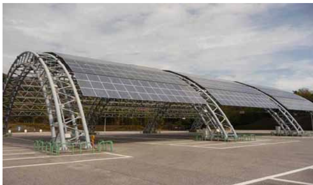
太陽光発電システム (のいち動物公園)
