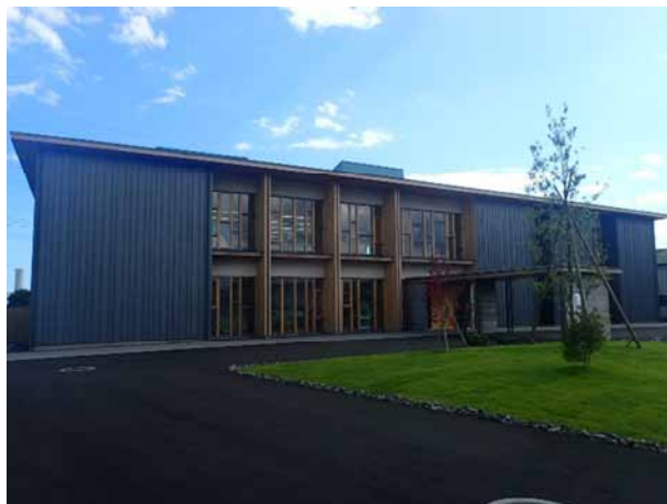
高知県森林組合連合会事務所(平成28年3月完成) (木造+CLT 2階 延べ床面積1,209 m^2 )
