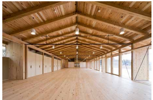
佐川町黒岩地区集落活動センター (平成29年3月完成) (木造 1階 延べ床面積319m 2 )
