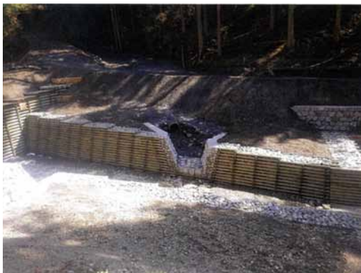
護岸工 (木製) 完成状況
