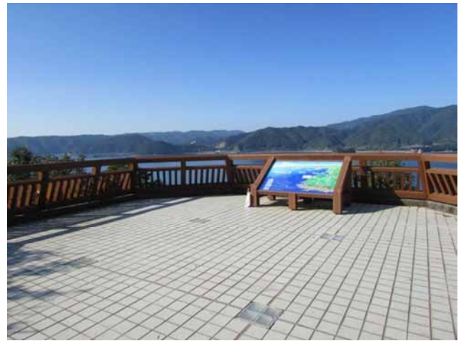
見残園地展望台手摺改築工事
