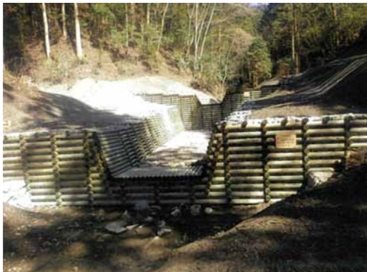
床固工 (木製) 完成状況
