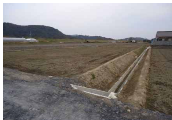
工事完成状況
