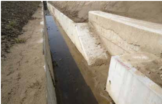
排水路完成状況
