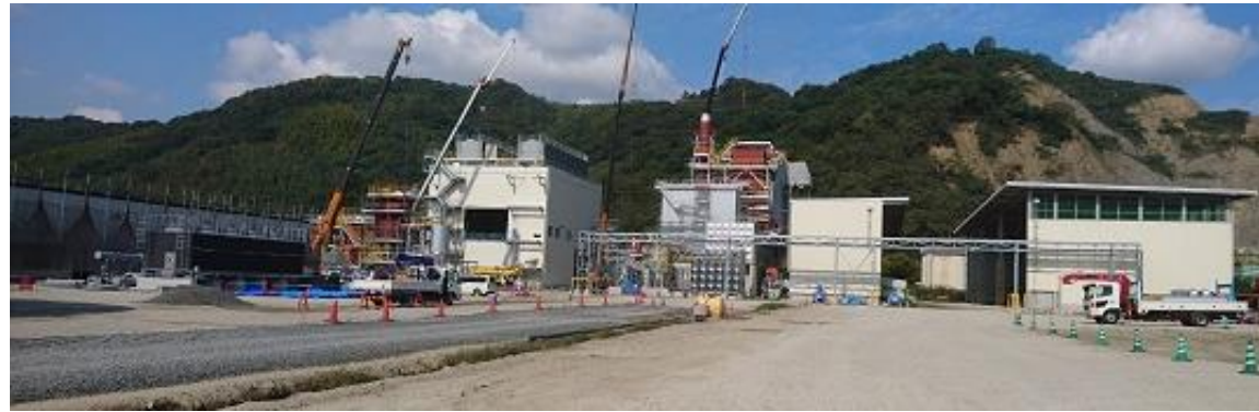
建設中のバイオマス発電所（10 MW）
