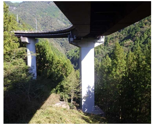
(国道194号 安望大橋 いの町)
