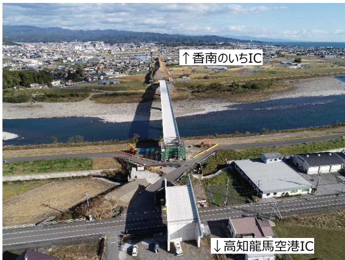
E55高知東部自動車道 南国安芸道路 (物部川橋付近)
