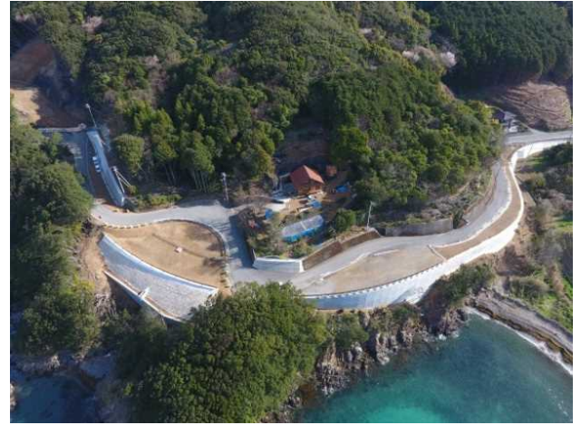
(県道安満地福良線 大月町)
