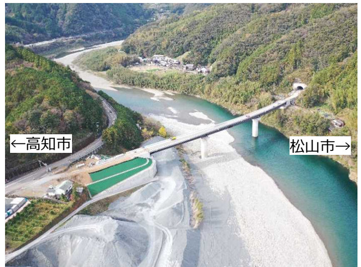
高知松山自動車道 越知道路(2工区) (横倉大橋)
