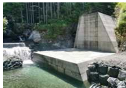
【谷山川 砂防えん堤】
