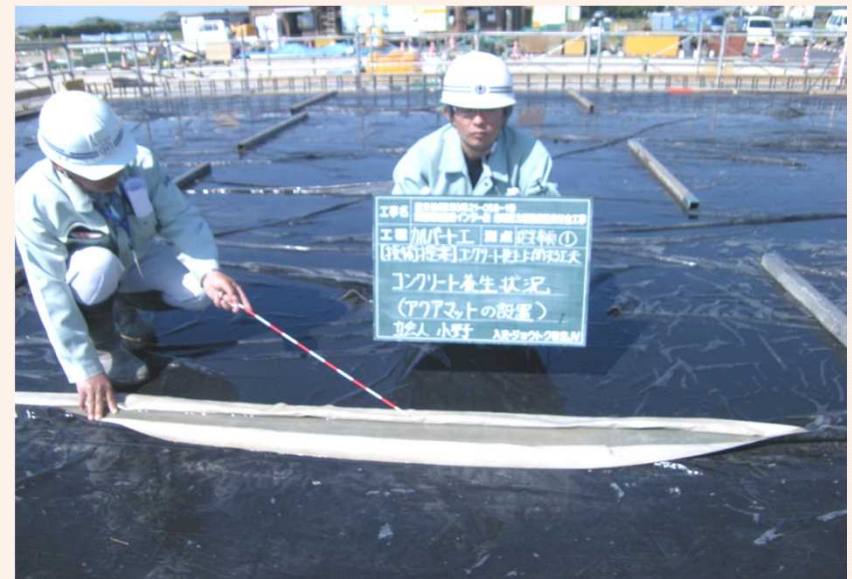
夏季におけるコンクリート表面積が大きい床版等での養生(保水効果に優れた養生マットの使用)
