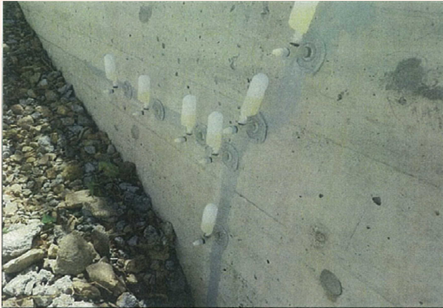
温度ひび割れの発生、補修状況
