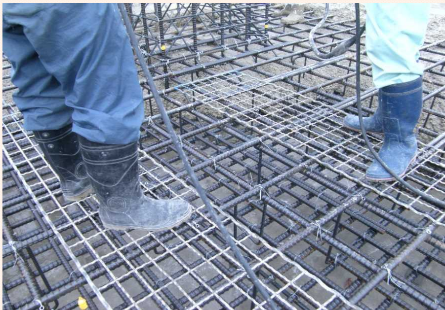
金網マット、鉄筋上面の作業性確保
