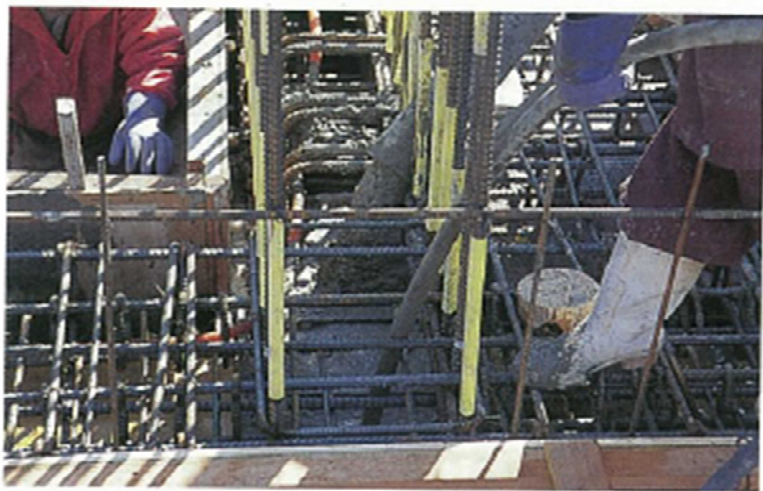
直径50mmのバイブレーターが挿入できるような鉄筋の密度にも配慮が必要
