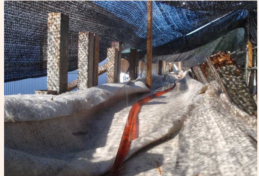
暑中コンクリートでの養生
