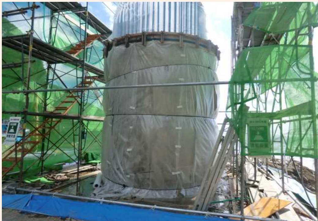
橋脚の養生における気泡緩衝材の使用
