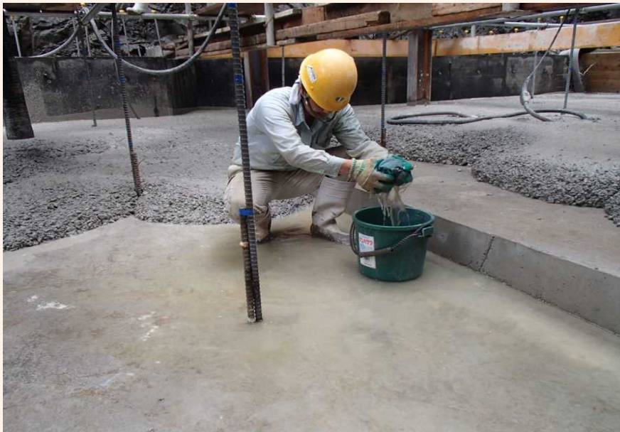
打設中のブリーディング水回収
