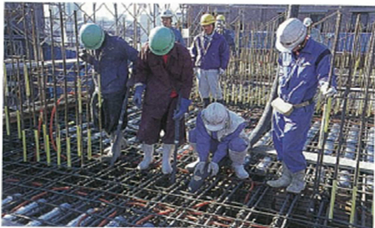
バイブレーターは、打設作業の進行方向の反対側で作業をする。上の写真では右側が進行方向
