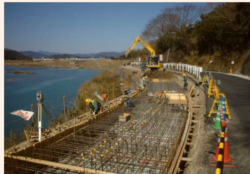
現道交通供用下のコンクリート工事
