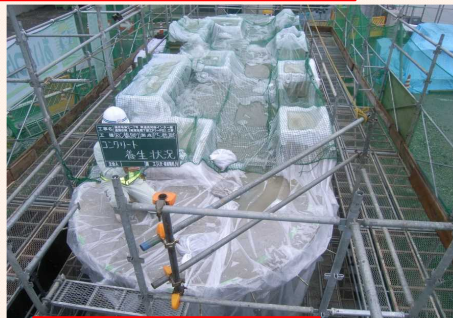
堪水養生+シート養生
