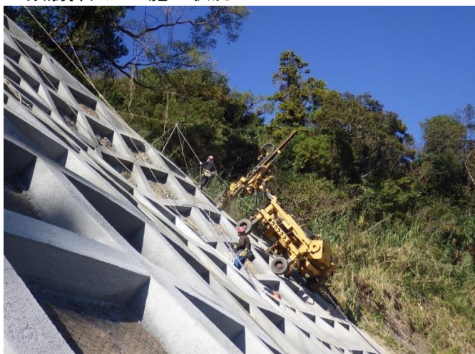
鉄筋挿入工の施工状況
