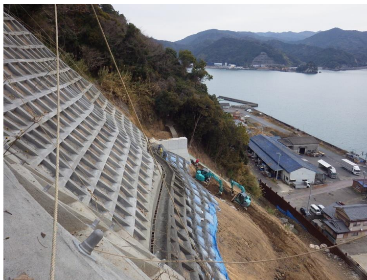
法枠工の施工状況
