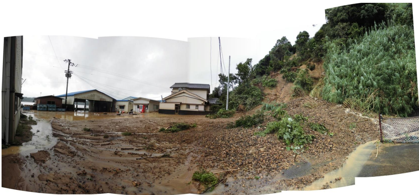
土砂流出状況(被災直後)
