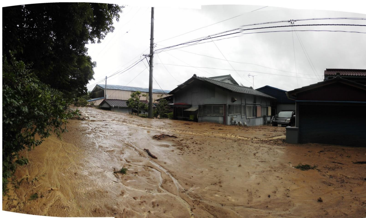
人家及び市道大島南線の崩土埋没状況
