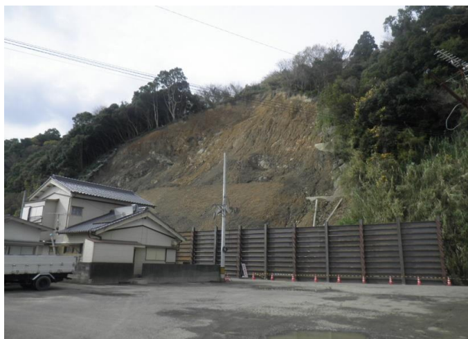
緊急応急工事 完了
