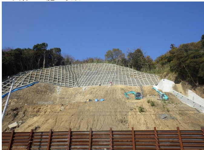
法枠工の施工状況
