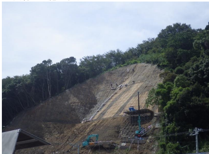
法枠工の施工状況
