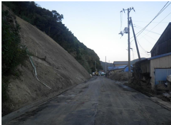
崩土除去完了
