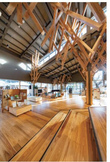
屋根を、徐々に高くなるようにずらして重ねることで、接続部分のすき間にある高窓から、外光が射し込む仕組み。
