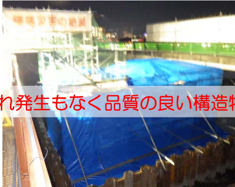
【P2橋脚 柱部 給熱養生 (全景)】
