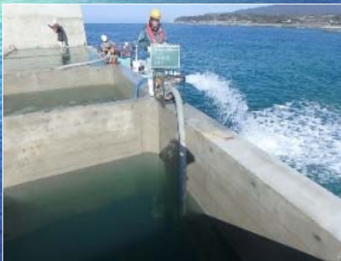
投入前ポンプ排水状況
