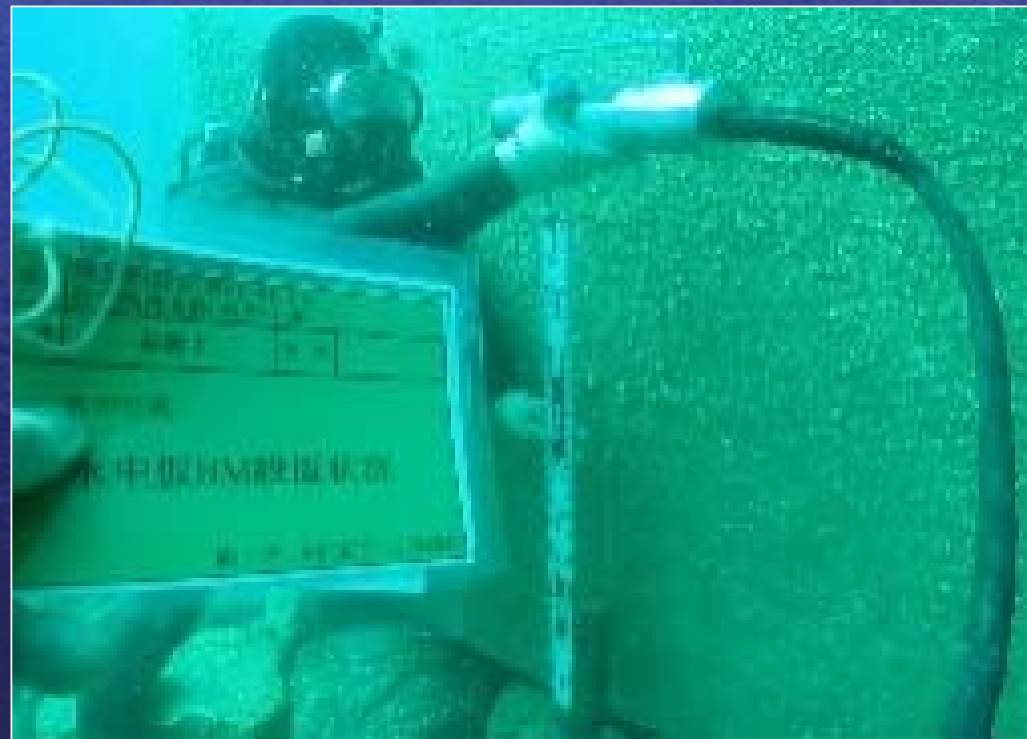
水中仮BM設置
