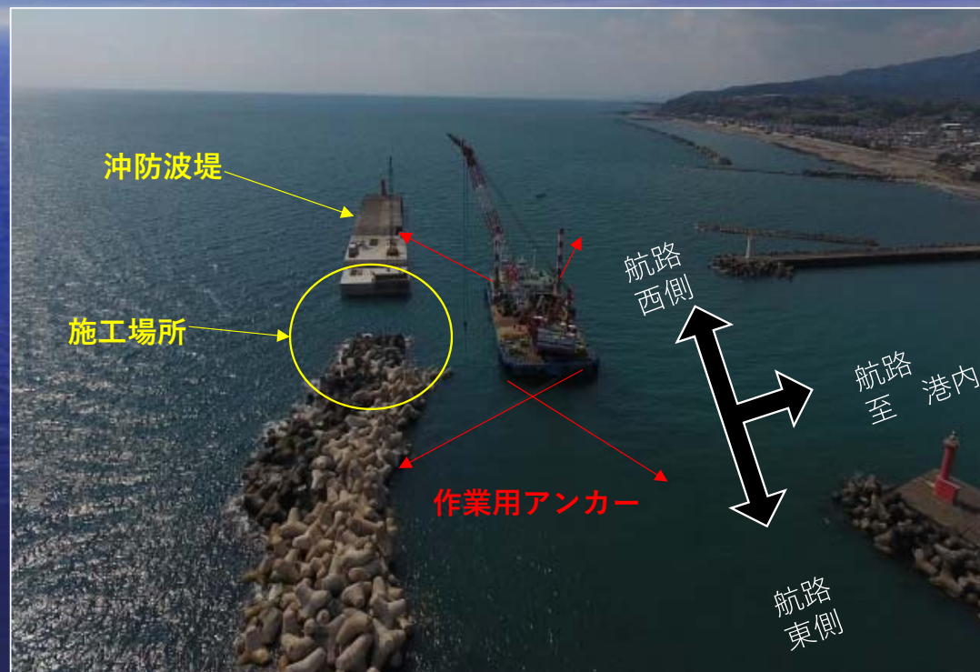
航路内での作業状況
