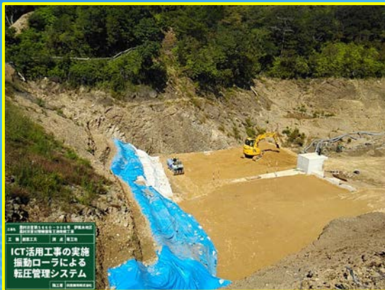
堤体盛土(転圧)施工状況
