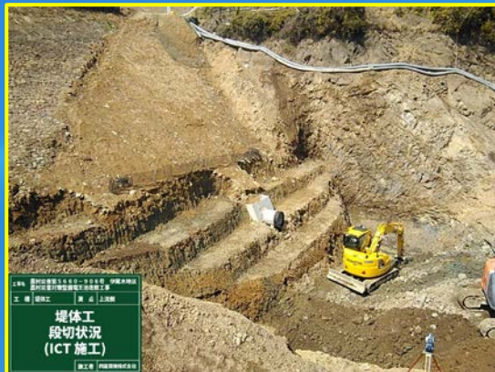
段切り掘削施工状況
