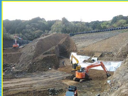
堤体盛土(敷均し)施工状況
