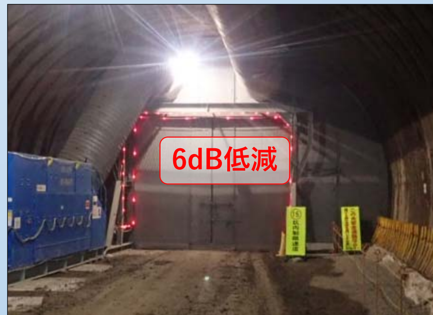
坑内に作業スペースが確保できた時点で防音扉を設置
