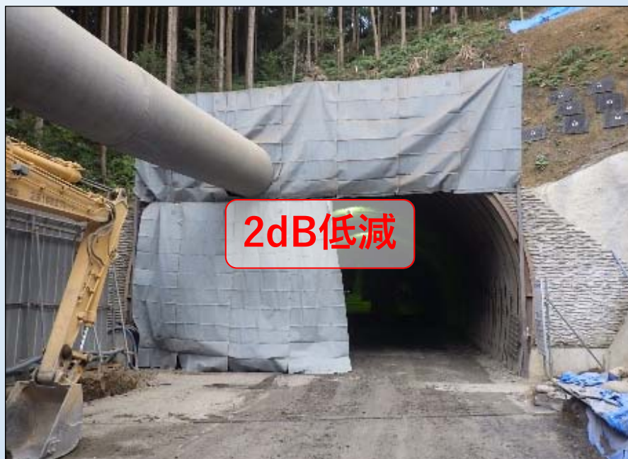
掘削初期は坑口に防音シートを設置
