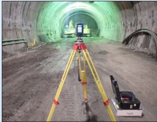
【作業中に計測】
