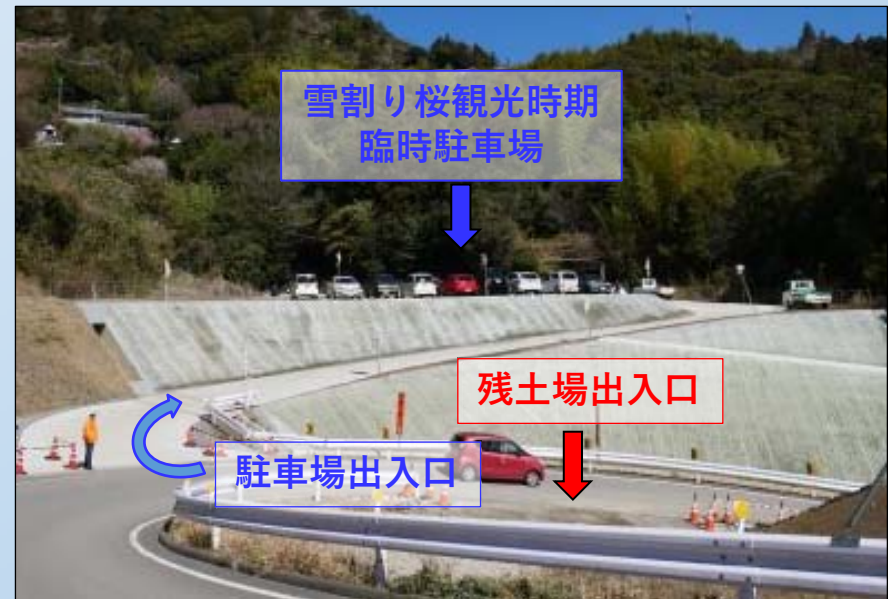
残土場出入口と臨時駐車場出入口が近接
