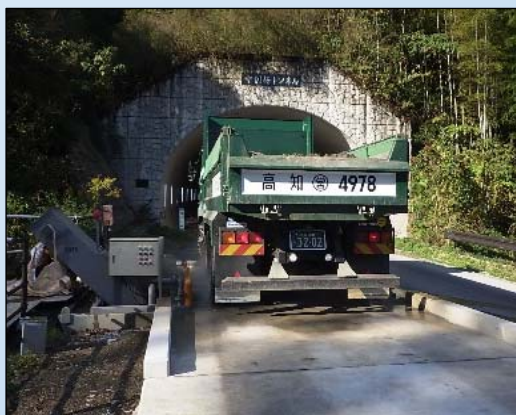
【タイヤ洗浄機：現場】
