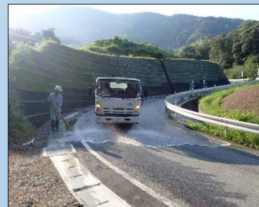
【路面清掃・散水】
