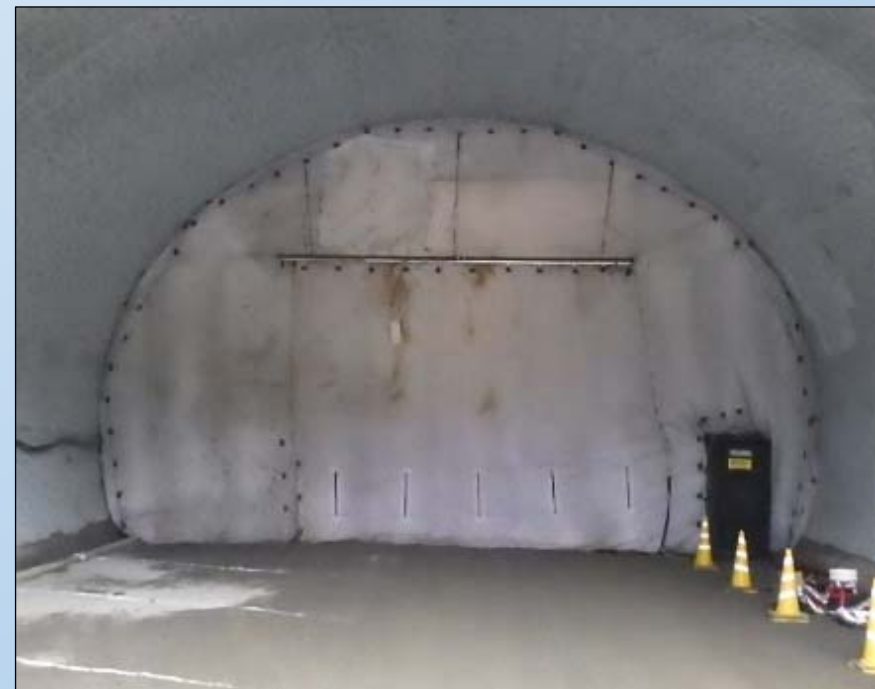
隔壁バルーン設置状況
