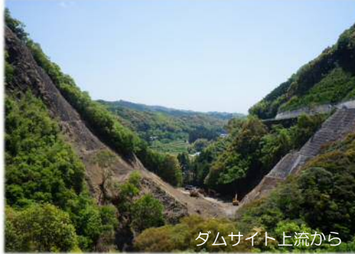
ダムサイト左岸側から
