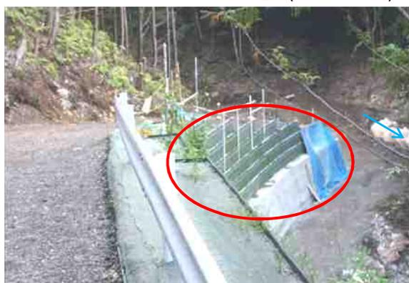
貯水池の上流で施工中の付替道路では、その足元となる、「基礎コンクリート」を施工中ながやき。
