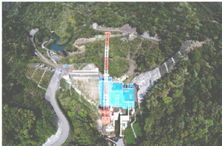
和食ダムは現在約49,000m<sup>3</sup>のコンクリート打設が完了し、進捗率は約78%です。堤体コンクリート打設については、左岸再掘削の準備のため今はお休み中です。現在は基礎処理工(貯水池の水がダムの底から漏れないよう地盤改良する工事)を引き続き行っています。また、工事の延長に伴い、みなさまには大変ご迷惑をおかけしております。1日でも早いダム完成に向けて事務所一丸となって頑張っておりまいますので、今後ともよろしくお願い致します。
