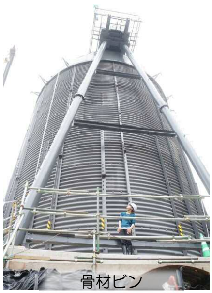
左：バッチャープラント（コンクリートを練る施設） 右：骨材ピン（コンクリートの材料を貯蔵する施設）
