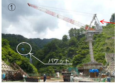
コンクリートを載せたバケットを移動
