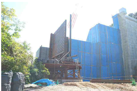
堤体付近の落石防護柵 堤体の上・下流まで柵を設置したら完成です
