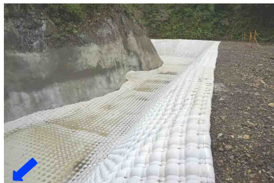
河川増水に備えた排水路(余水吐き)
