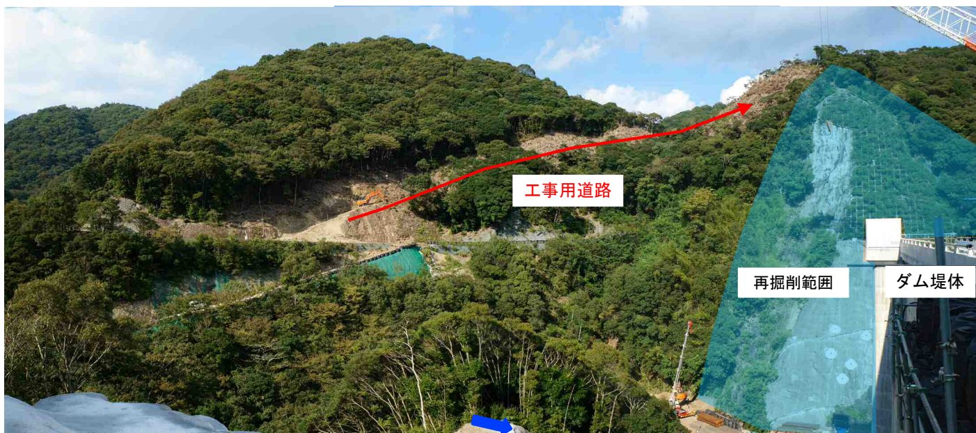
右岸側から見た工事用道路施工箇所
