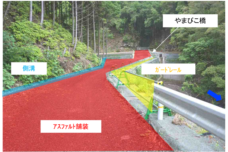
付替道路工事予定箇所
