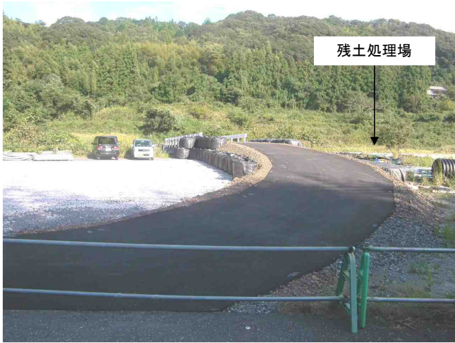
完成した残土処理場へ続く工事用道路
