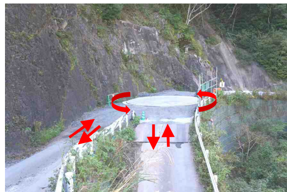
設置が完了したターンテーブル ドライバーは専用リモコンまたは操作盤で回転台を動かします
