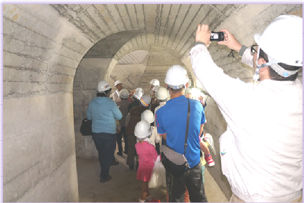
ダム内部の通路
