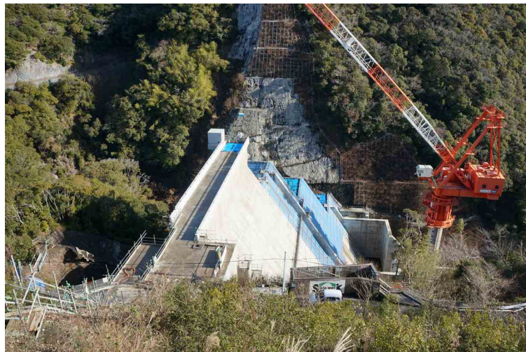
右岸山側からみた和食ダム
