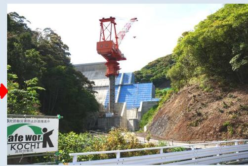
タワークレーン自らタワー部分を上から吊って抜き取り高度を下げていきます。
