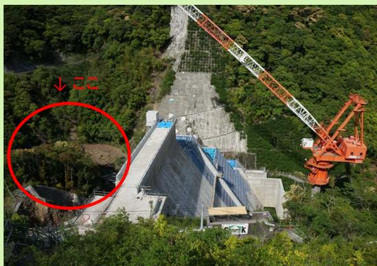
左岸再掘削にむけて、ダム上流で土砂集積ヤードを造成しています。
