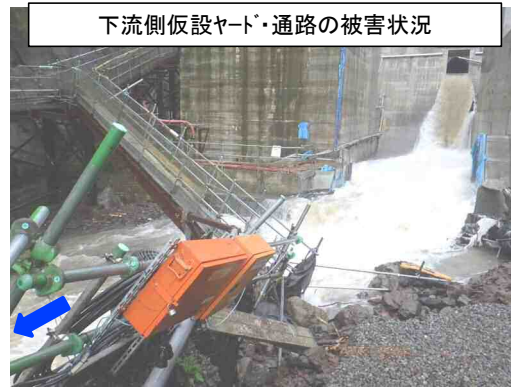
転流工盛土・土のうが流出し、排水管が露出
