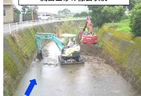
流出土砂の撤去状況
