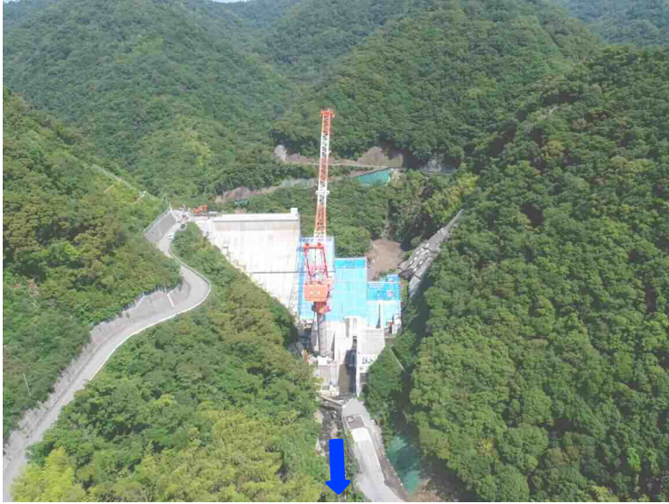
下流側から望む和食ダム
