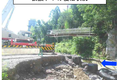
仮設ヤードの復旧状況
