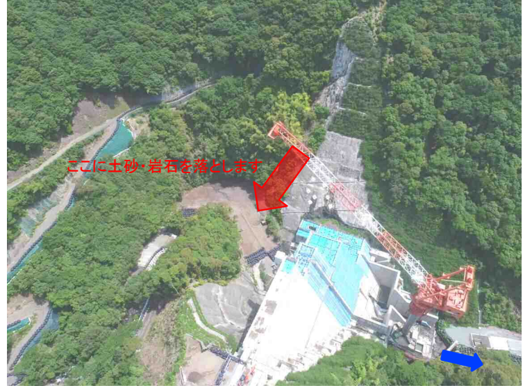
右岸側から望む和食ダム
