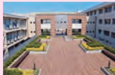
⑤屋上庭園・駐輪場
