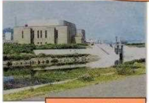
内水排除施設
