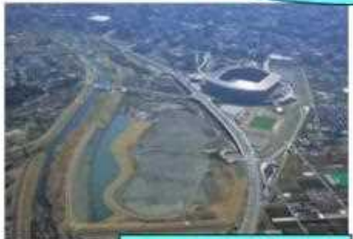
洪水調節施設
