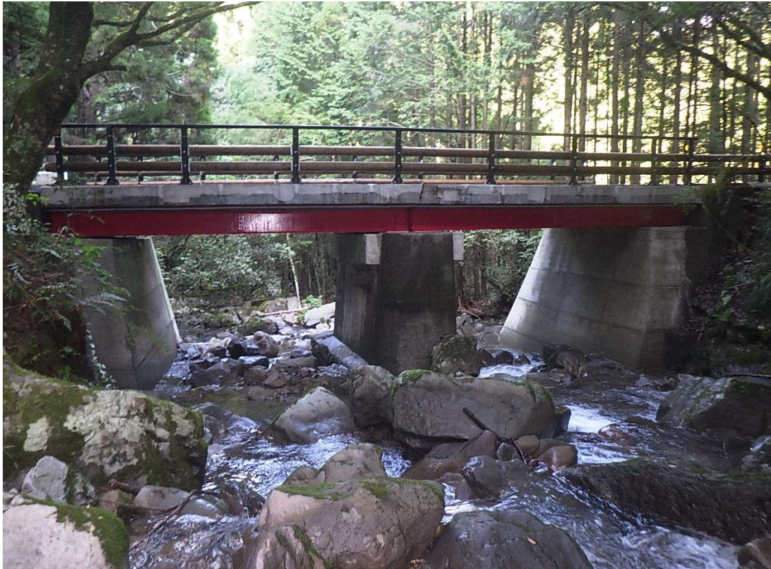
橋梁耐震(落橋防止装置) 1式 橋梁補修(断面修復工、ひびわれ補修工、橋梁塗装工) 1式
