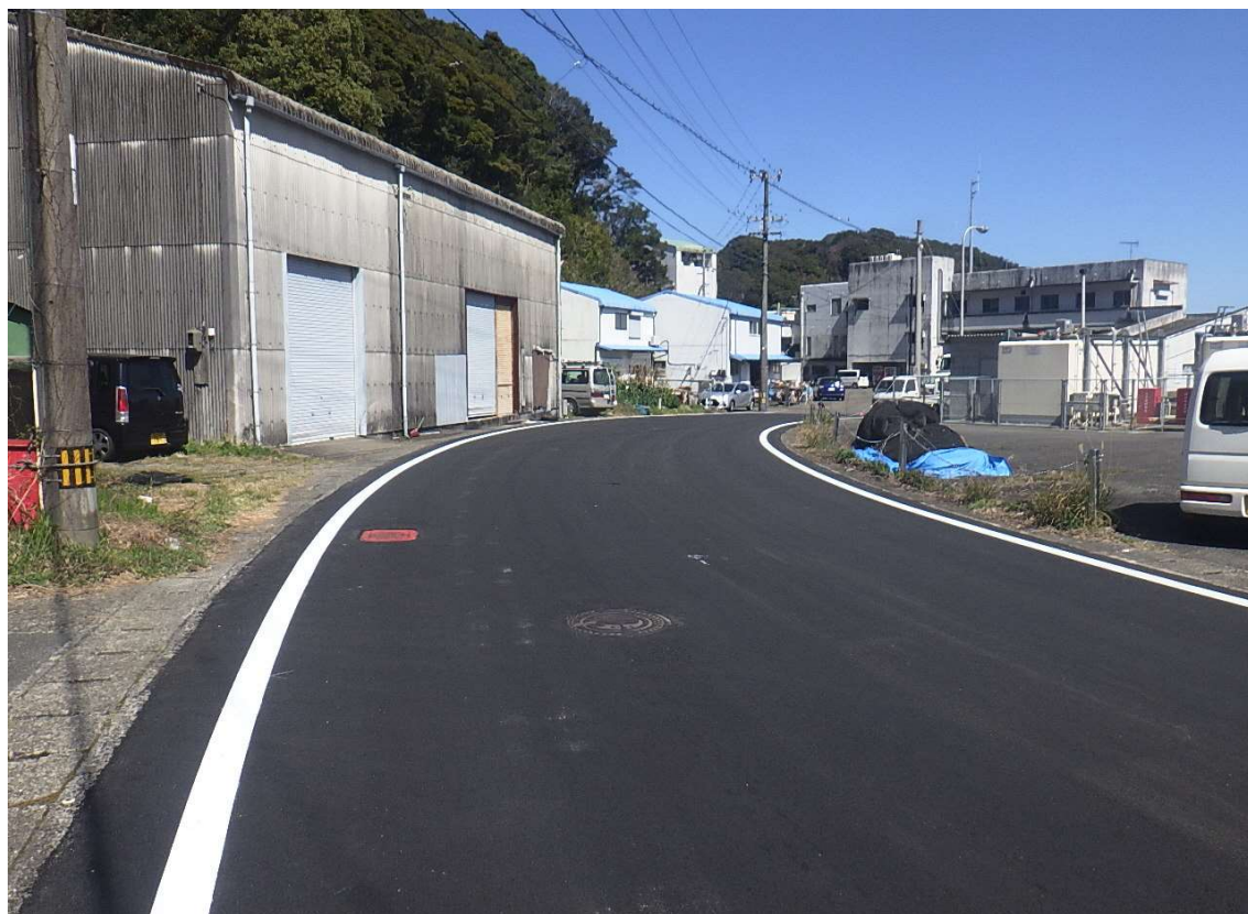
1工区(舗装工、区画線設置工、排水工)
