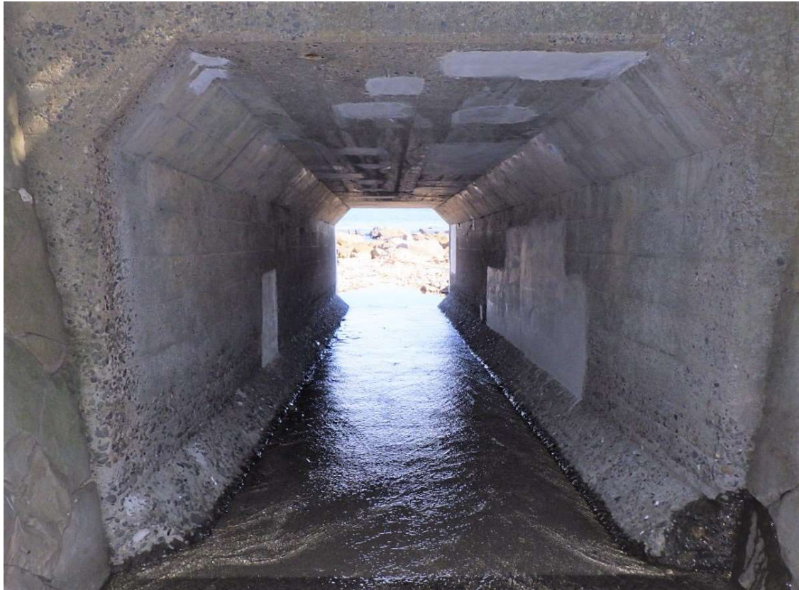
断面修復工 N=1箇所
