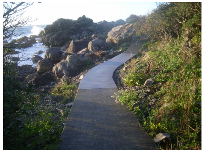
室戸岬園地遊歩道災害復旧工事
