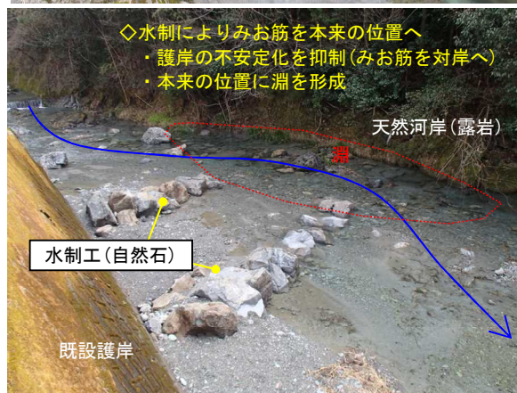
水制設置箇所(工事完了直後)
