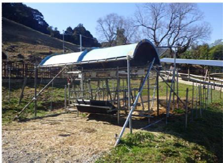
写真1 廃材を用いた簡易管理施設
