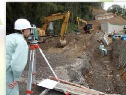
土木専攻 測量実習
