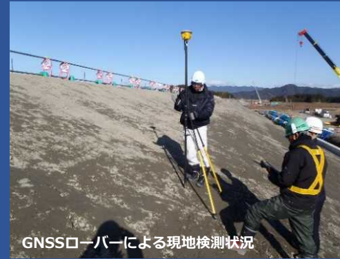
3次元点群データの解析を行い、ヒートマップによる目視確認にて検査を実施
