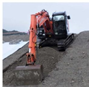
この写真は、3次元設計データ（斜面の傾きや高さなど）をICT建設機械に読み込ませ、施工位置をモニターや音声で確認しながら作業をしています。
