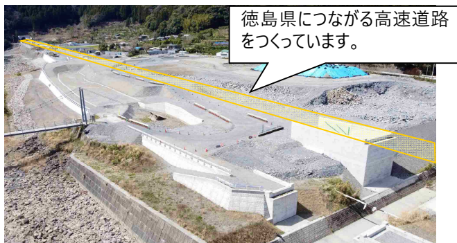
北川道路（北川村和田）（ICT 施工※）
