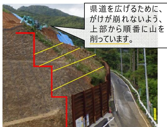
県道南国伊野線工事（高知市鏡）（ICT 施工※）
