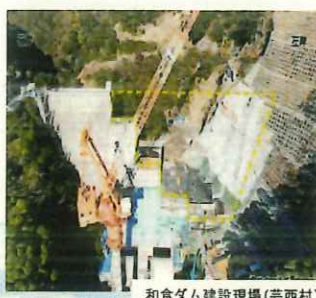
和食ダム建設現場(芸西村)
