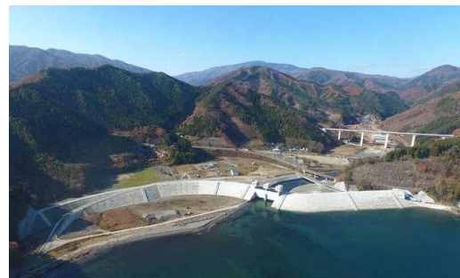
出典：【No.49 小白浜海岸】現地写真 岩手県HP
