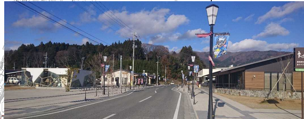
写真① 公園、商業施設の立地状況 (高田地区2019.12)
