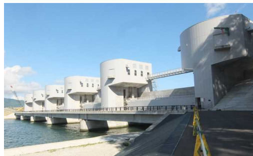
出典：岩手県HP 津波対策施設の復旧、整備箇所
