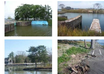
■貞山堀に関する施設
