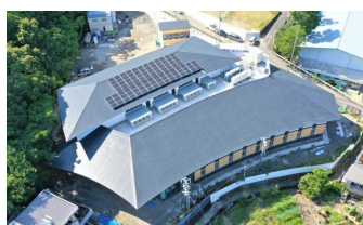
安田町役場（高台移転） R2.7竣工 出典：安田町ホームページ
