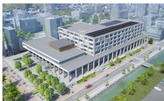
高知市役所（現位置再建） R1.11竣工 出典：高知市ホームページ
