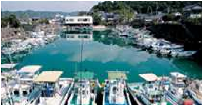
例 藩政時代に開削された漁港（土木遺産）
