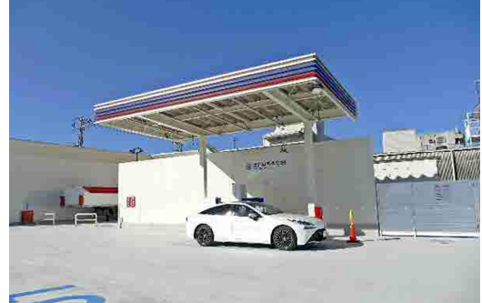
高知水素ステーション
