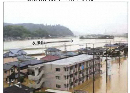
愛媛県大洲市の浸水状況
