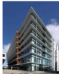
香南市庁舎(7階建て) ※耐震壁にCLTを使用
