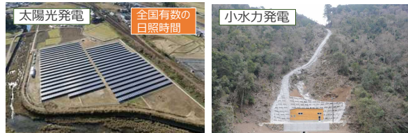
こうち・さかわメガソーラー発電所
