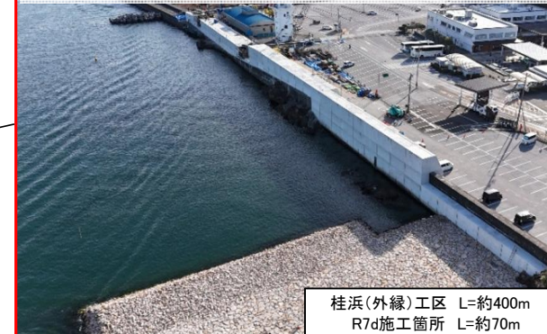
桂浜(外縁)工区 本体工(R8.1撮影)
