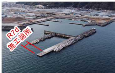
防波堤(東第二) 本体工、被覆・根固工(R8.1撮影)
